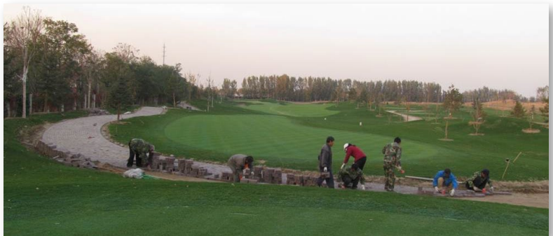
上图：天津龙海国际乡村俱乐部的沙坑膜铺设 下图：球场上的部分植草已完成，工人开始进行球车道施工
